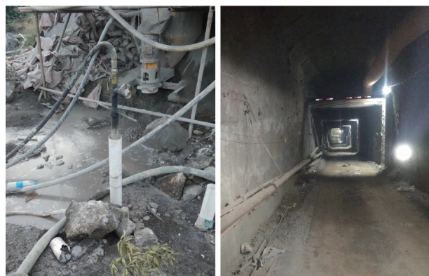
图10 现场注浆及注浆后的隧道效果
