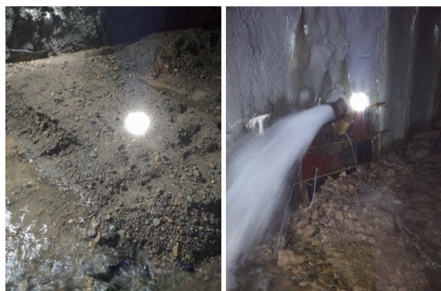
图2 洞内积水及涌水情况
