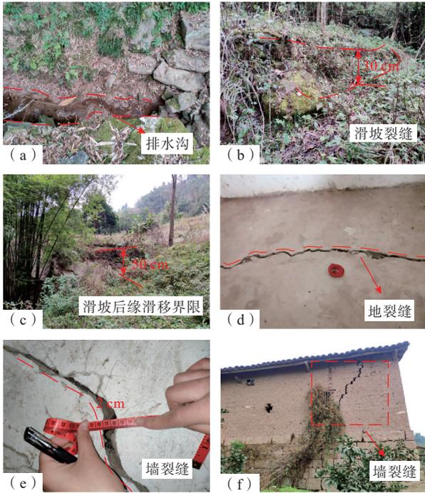
图 2 滑坡区变形和裂缝照片
