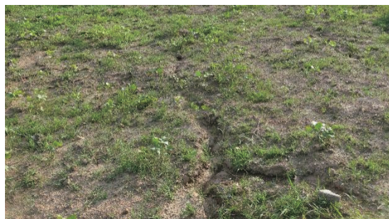
图3 洞口段地表裂缝
