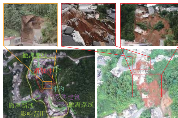
(a) 滑坡未失稳前卫星影像图 (b) 滑坡失稳后航拍图
