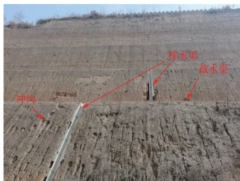
(a) 削坡+截排水+防护网 (小峪峡)
