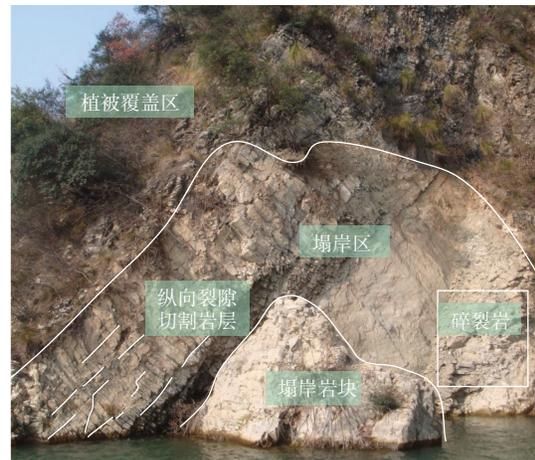
图 3 龚家坊斜坡局部岩体结构
