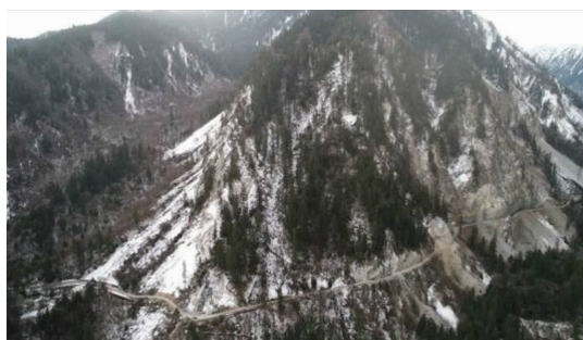
图1 老虎嘴路段震后航拍图
