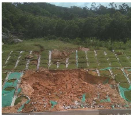
图 2 浅层滑坡情形
