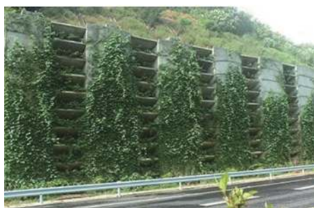
图 4 斜插式桩板墙示意图和实例
