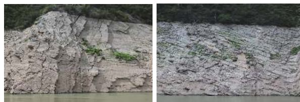
图 9 岸坡消落区岩体劣化特征图
