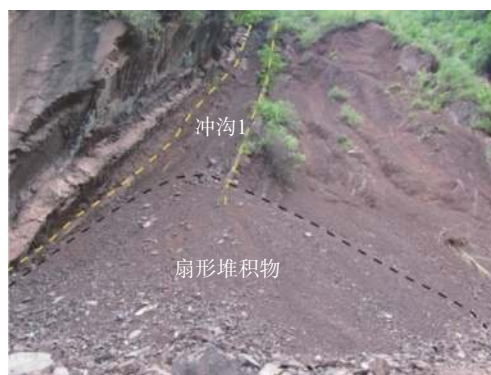
图 8 边坡坡脚处的堆积物
