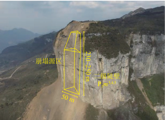
(b) 甑子岩崩塌源区 (W12)
