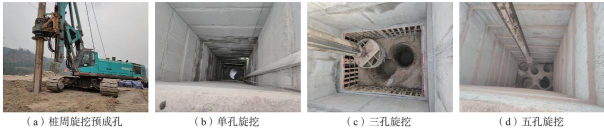
图 5 “桩周旋挖引孔开挖回填+桩芯旋挖取土+人工辅助清边”实景图
