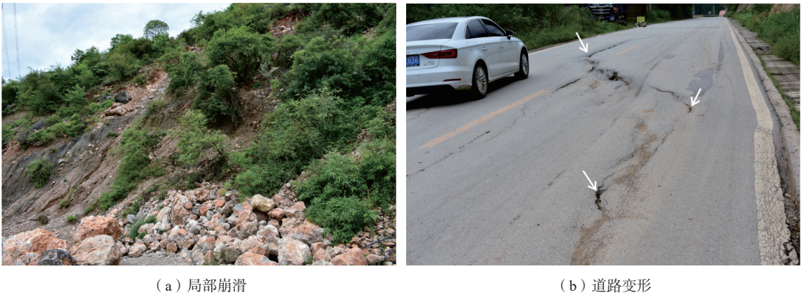
图 13 下麦地隧道出口段不良地质体现场照片 Fig. 13 Scene photograph of the exit section of Xiamaidi tunnel
