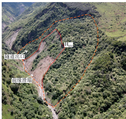
图 11 滑坡 H 031 无人机影像
