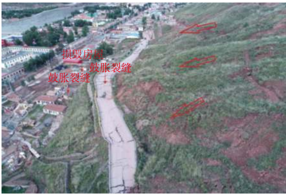
图 4 曲哇加萨“9·20”滑坡前缘 Fig. 4 Frontal edge of “9·20”landslide in Quwajiasa
