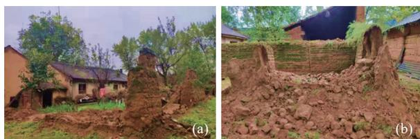
图 6 湫坡头镇夯土墙倒塌情况
