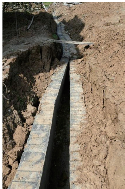
图 14 滑坡致滑坡右侧排水沟合拢
