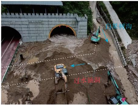
图 5 泥石流淤埋高速公路(镜向 NW)
