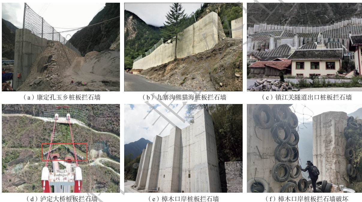
图 1 典型桩板拦石墙结构
