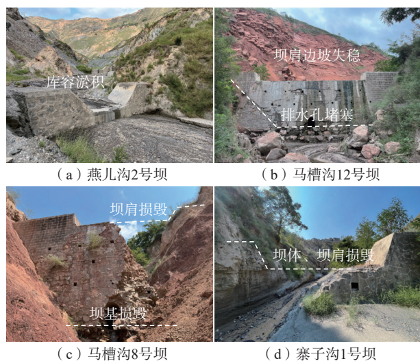
图 3 拦挡坝典型损毁类型
