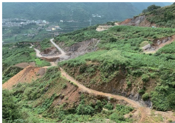
图 1 金阳县新区建设开挖形成的陡坡
