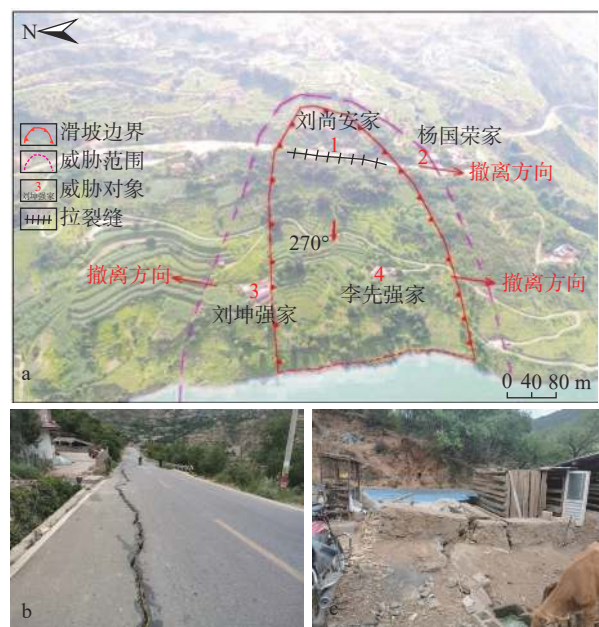
图 9 木里县瓦厂镇纳子店村店扎组滑坡 Fig. 9 Diancha Formation landslide in Nazidian Village, Wuchang Town, Muli County 注: a 为全貌; b 为滑坡后部裂缝; c 为滑坡后部垮塌猪圈。
