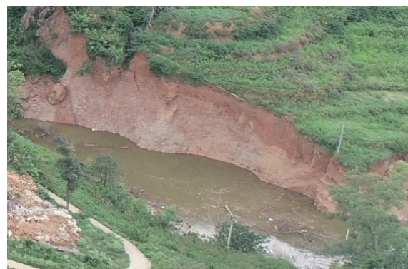
图 8 白鹤滩电站边坡前缘塌岸
