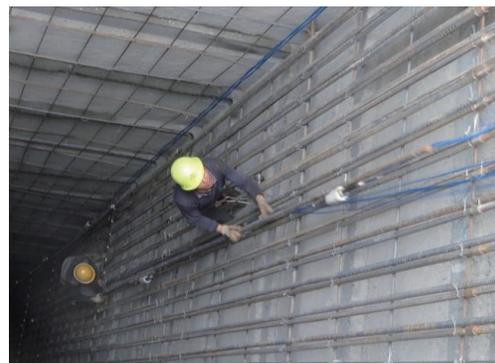
(a) 抗滑桩钢筋计与混凝土应变计安装
