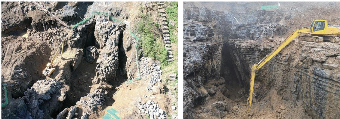
图 4 挡墙基础岩溶开挖图
