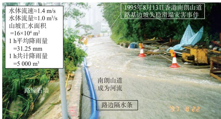
图 19 香港南朗山道跨流域调水、汇入山坡径流形成河流的现场照片
