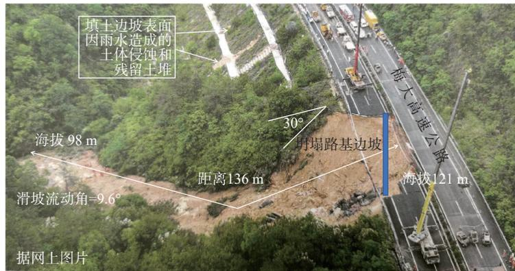
图 12 路基边坡失稳滑坡后现场照片和沿 C 冲沟最小滑移距离和高程
