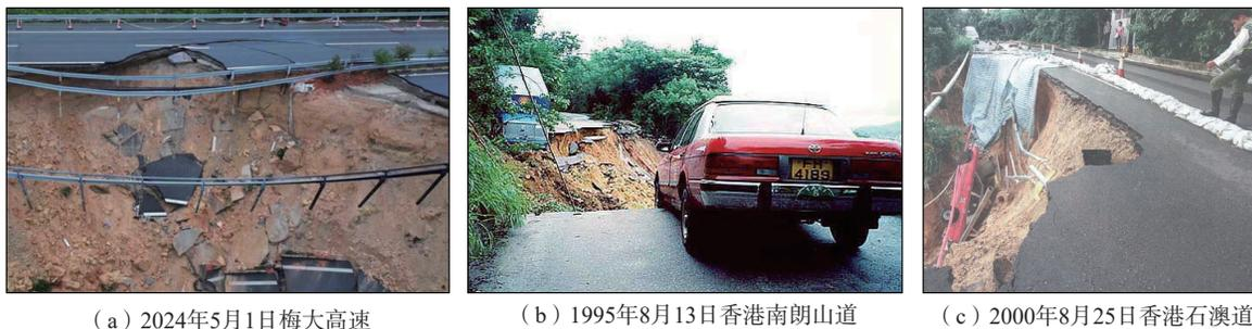
图 1 路基边坡失稳滑坡的 3 个实例
