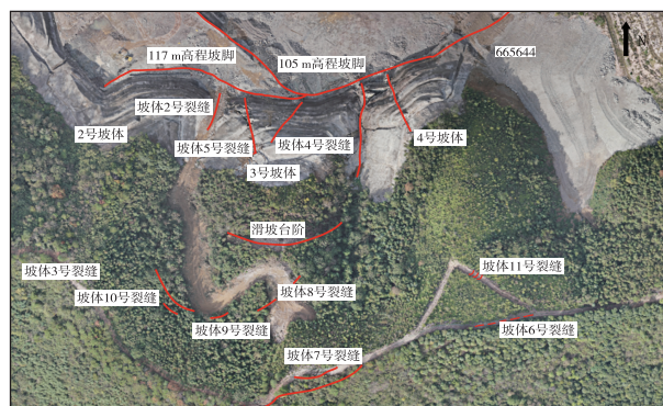
图 2 金华市某岩质滑坡全貌图
