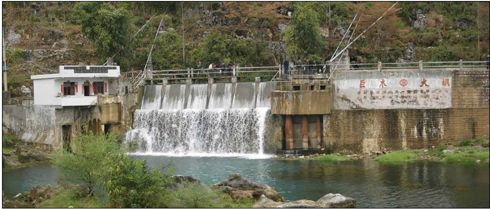
图 5 贵州省平塘县巨木地下河筑坝拦蓄工程
