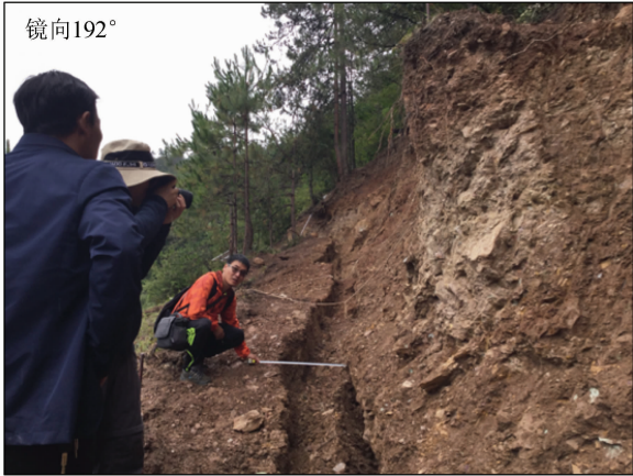
图 4 滑坡后缘裂缝(2019 年 7 月 9 日) Fig. 4 Crack on the back edge of landslide (July 9, 2019)
