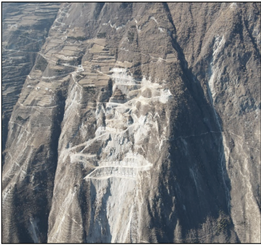
(b) 坡体变形及裂缝发育调查
