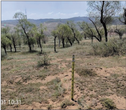
(b) 2022 年 7 月裂缝状态
