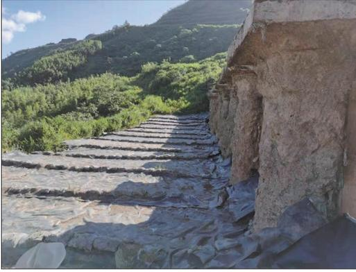
图2 滑坡后缘错落坎
