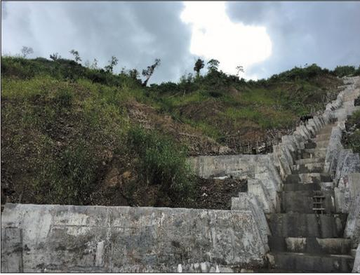
图3 滑坡前缘已建树根桩排导槽
