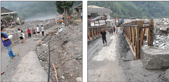
(a) 泥石流堆积区 (b) 泥石流沟口
