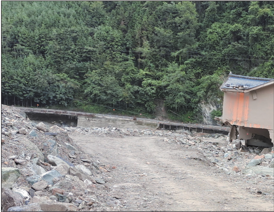
图 3 卿家沟泥石流异岸冲蚀照片
