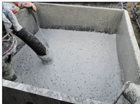
图 8 现场配置堵漏树脂凝胶浆液
