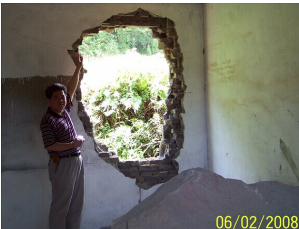
图12 崩落巨石损坏的校舍及散落在校园中的巨石
