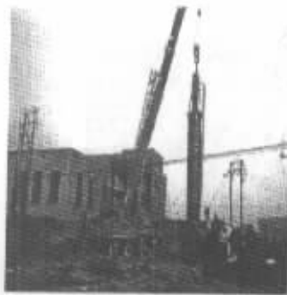
图 5 钢管正吊运至桩位
