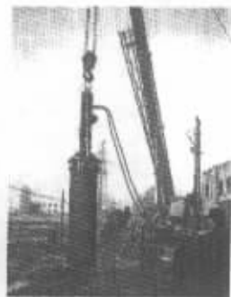
图 6 夯管作业进行中
