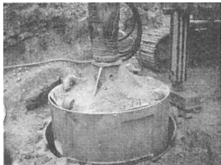
图 1 \varnothing 2200 mm 气举反循环筒式牙轮钻头 (在储渣筒内充满了岩渣)
