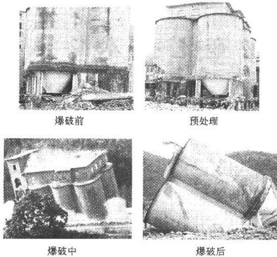
图 2 双排水泥窑爆破过程
