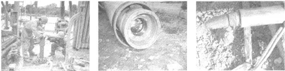
图 5 钻进取样试验施工现场及取出的样品
