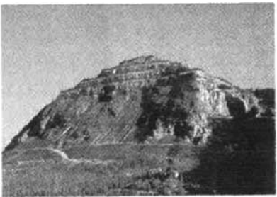
图2 治理后边坡全貌
