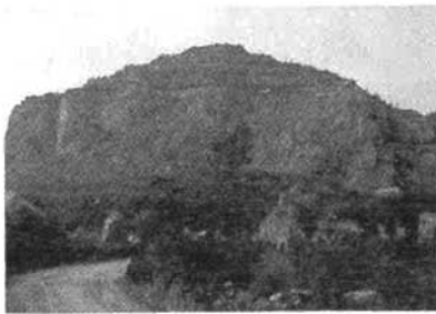
图1 治理前边坡全貌
