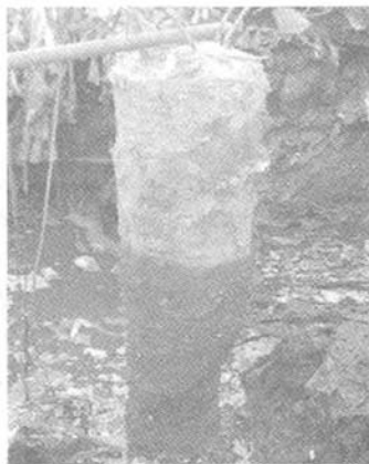
图 4 某中心 III 区 129 号桩开挖情况
