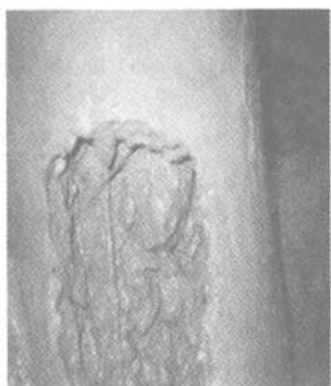
图13 某花园 D10 号楼 124 号桩开挖情况
