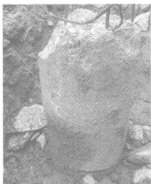
图15 某花园 G03 号楼 12 号桩开挖情况
