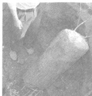
图10 某花园G02号楼155号桩开挖情况
