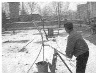
图 7 人工惯性泵洗井
