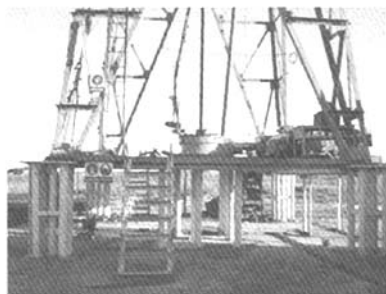
(b) 施工现场
