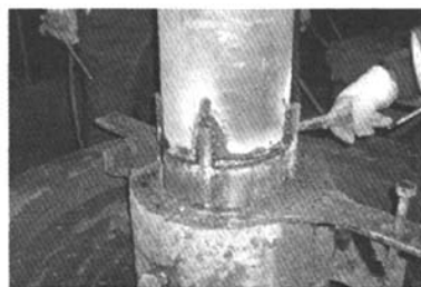
(a) 管体井口焊接
