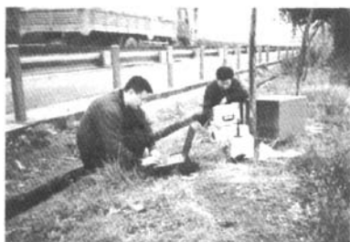
图6 内宜路现场数传电台调试情况
