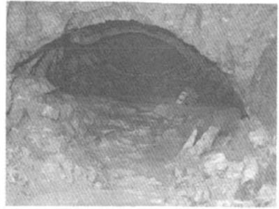
图2 某地岩石非开挖钻孔中钻屑充填截面图
