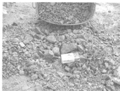
图 3 采用反循环工艺清除的钻屑
