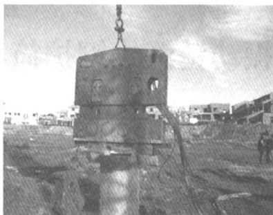
图2 振动锤施工现场
