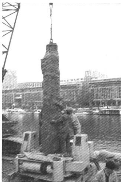
图8 天津海河拔除灌注桩
