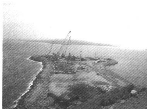
图6 跨海大桥主桥墩施工现场
