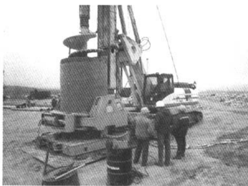
图7 CGJ-2000S 搓管机钻进现场
