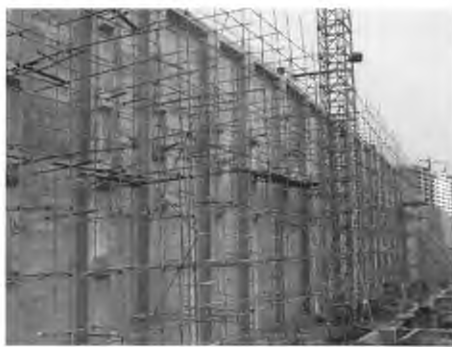
图 5 建设中的滨江大道挡土墙锚固工程
