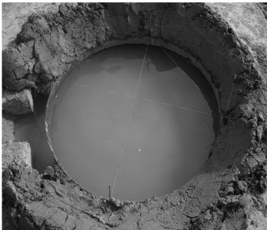
图 1 埋设好的孔口护筒
