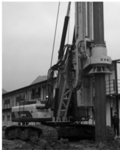
图 3 钻机施工现场
