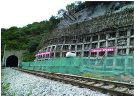
图 4 边坡加固结构施工现场照片
