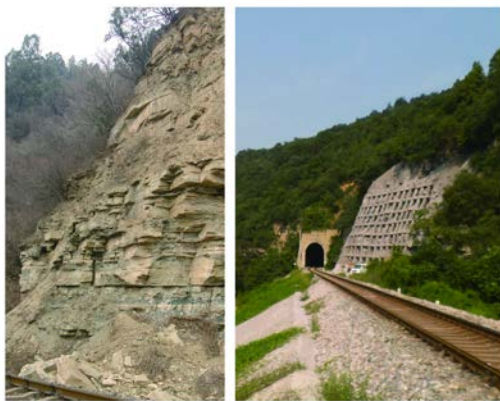
图 1 边坡灾害隐患情况及治理竣工照片
